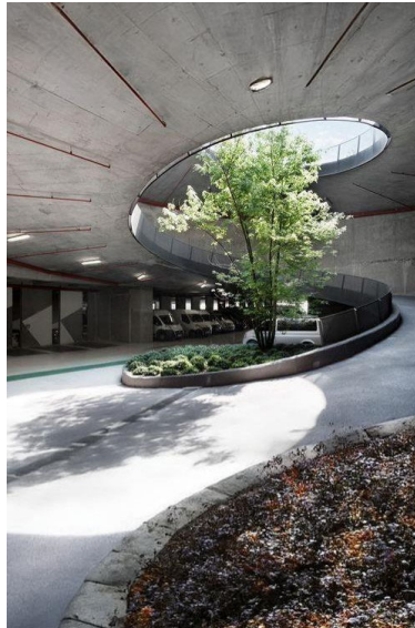
Parkering i kælder
